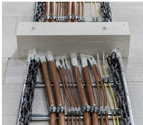
▲ Příklad montážního detailu - zachycení svislého tahu.
